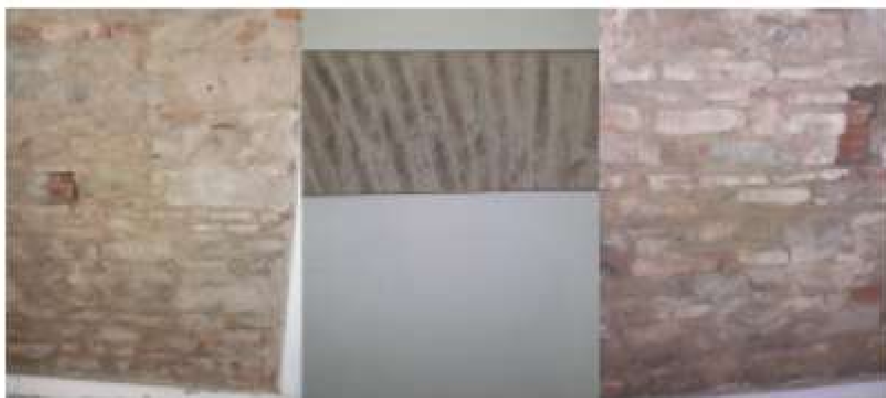
Fig. 1 Tipo de mampostería de la Iglesia San Francisco
