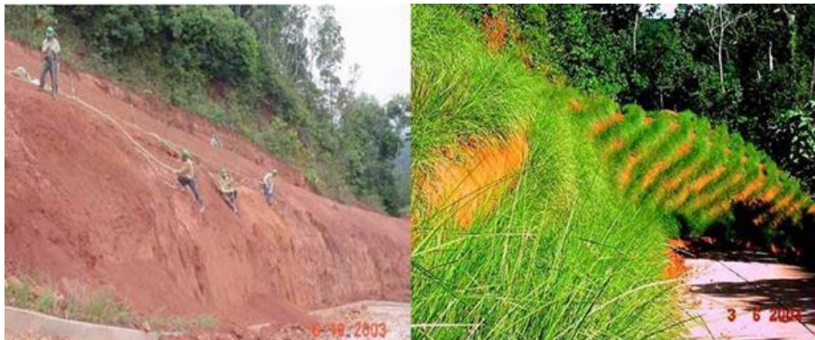
Figura 4. Usos del pasto vetiver 6 en la protección de taludes, como factor mitigante para los procesos erosivos, en vías de tránsito de fuerte pendiente y con problemas de caída de bloques de piedra, antes (izq.) y después (der.), en la mina de bauxita de Los Pijiguaos, estado Bolívar. Fuente: Rafael Luque, años 2003-2004.
